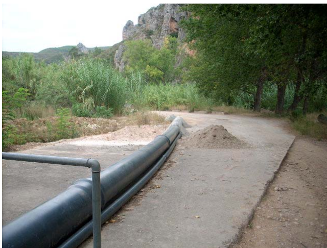
Foto nº 1: Detalle de la instalación de tubería de polietileno
